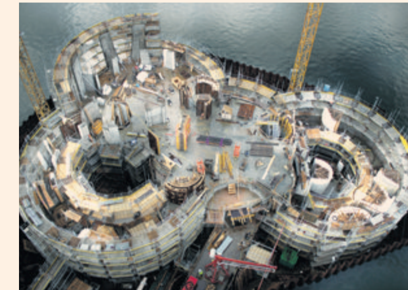
Het hoofdkantoor in aanbouw van Kirk Capital in Vejle. Het gebouw is Odico's grootste opdracht tot nu toe.
